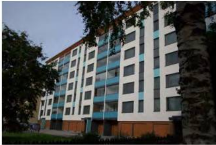
Kuvissa 1960-luvulla rakennettu kerrostalo ennen ja jälkeen perusparannuksen. (Kuvat lainattu Vähähiilisyysoppaasta)
