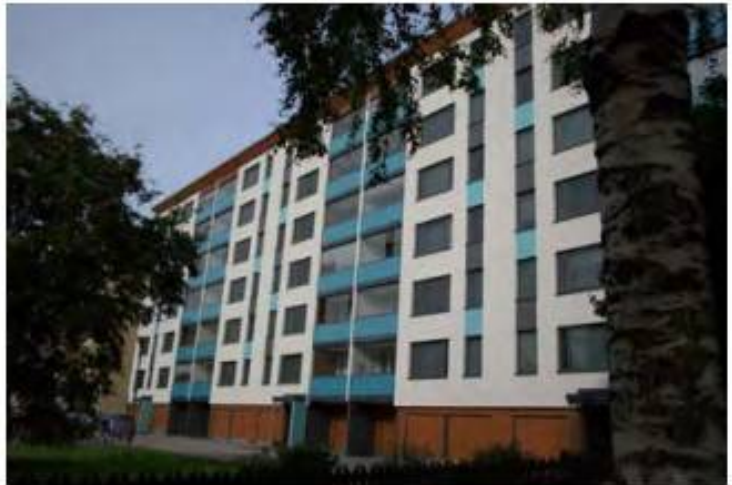
Kuvissa 1960-luvulla rakennettu kerrostalo ennen ja jälkeen perusparannuksen. (Kuvat lainattu Vähähiiliisyysoppaasta)
